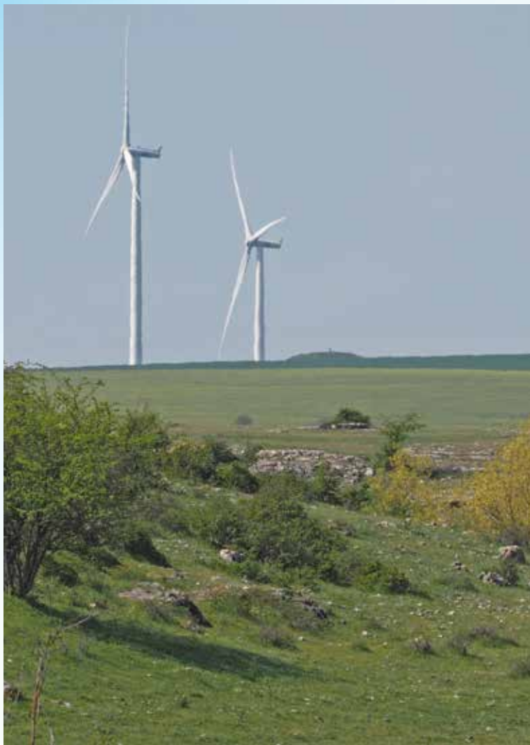
Exploatarea energiei eoliene în preajma unei arii protejate și în apropierea unui culoar de migrație. Se încadrează la codul D01.
