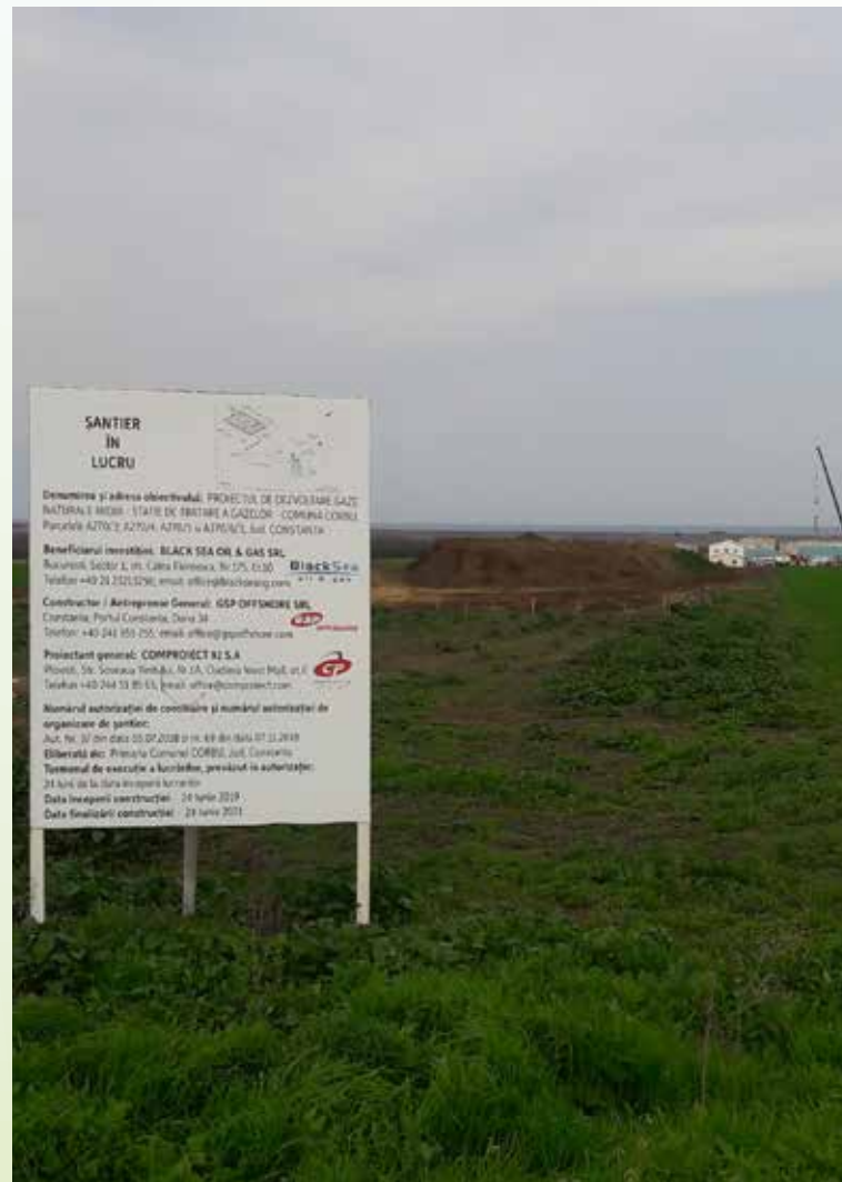
Șantier pentru un proiect de transport gaze în zona culoarului de migrație aflată imediat la sud de complexul lagunar Razelm-Sinoe. Se încadrează la codul D07.
