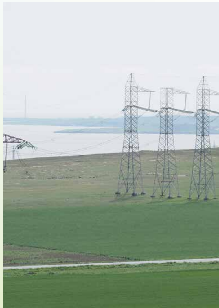
Infrastructură pentru transportul energiei electrice în apropierea culoarului de migrație din lungul țărmului mării. Se încadrează la codul D06.
