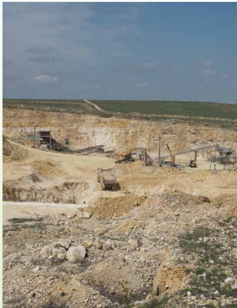
Exploatare într-o carieră de calcar de mare întindere, închisă inițial în anii 1970. Zona este utilizată pentru cuibărit și oprire pe perioada migrației de un număr mare de specii protejate, în primul rând specii prădătoare de zi și de noapte. Se încadrează la codurile C01, C06, C13 (prin poluarea fonică).
